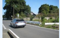
植木があり、東西に横断する児童が見えにくく危険である。横断歩道や用水路の柵があると安全。
